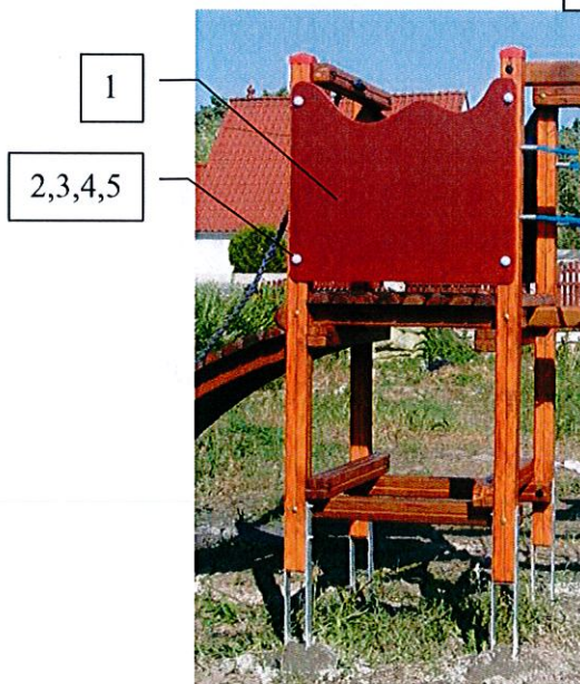
Foto. G1.1 Boczek falisty zamontowany do wieży w4.
