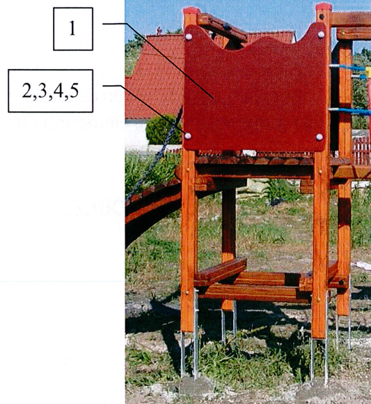
Foto. G1.1 Boczek falista zamontowany do wieży w4.
