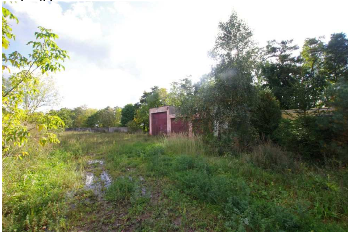
Fot. nr 11 Teren zaplecza biurowo – technicznego składowiska – obiekty budowlane, place utwardzone przeznaczone do rozbiórki.
