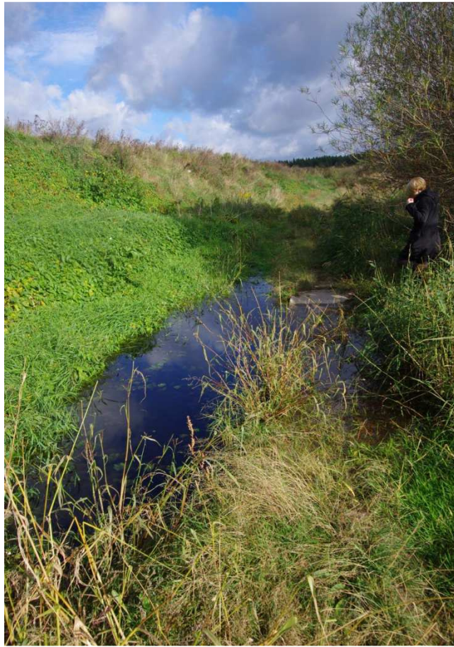
Fot nr 4 Wschodnia skarpa kwatery składowiska na działce nr 595/1
