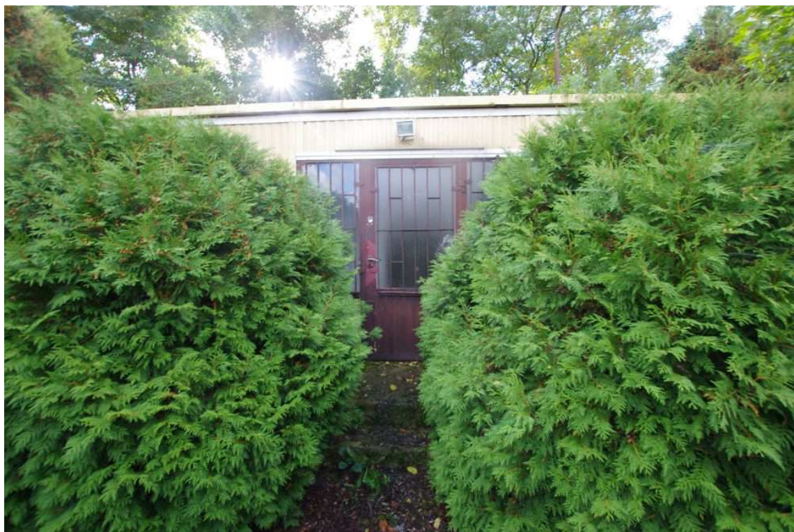
Fot. nr 12 Budynek zaplecza biurowego do rozbiórki.
