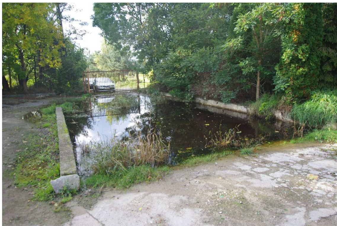
Fot. nr 3 Brodzik dezynfekcyjny przy wjeździe/wyjeździe na składowisko – przeznaczony do likwidacji
