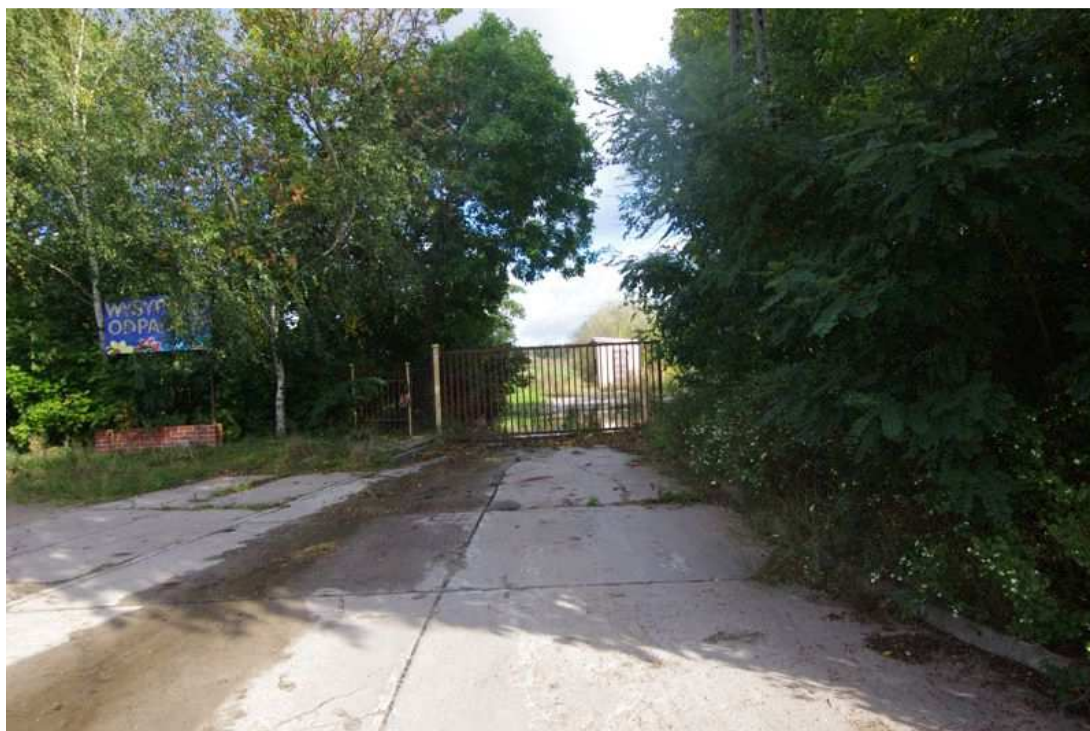
Fot. nr 1 Część południowa składowiska –wjazd na składowisko
