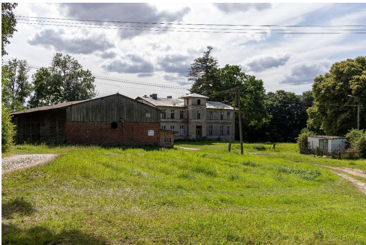
Zdjęcie 9. Istniejąca zabudowa w granicach projektu planu
