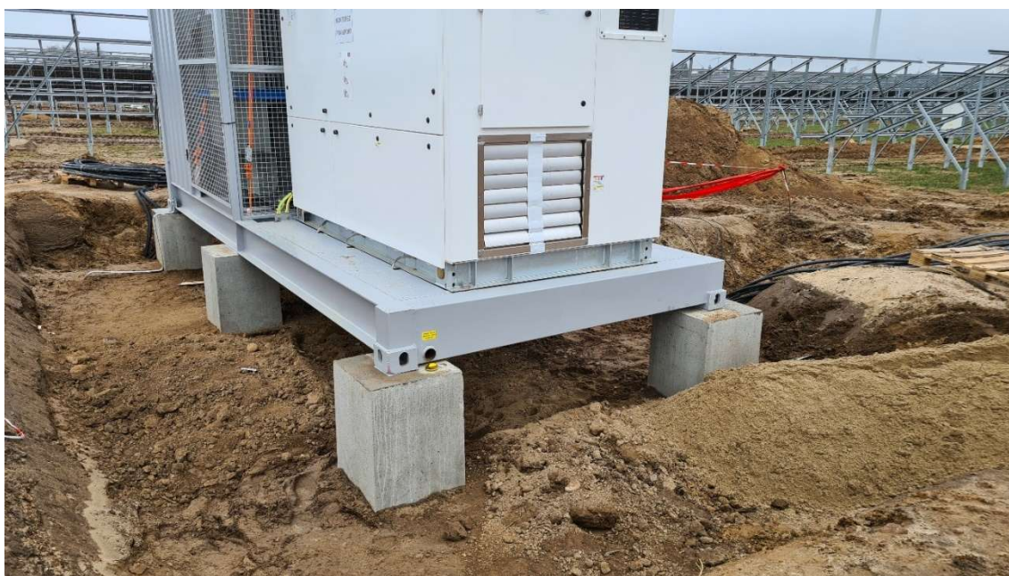
Zdjęcie 13. Przykładowy fundament pod stacją – etap budowy (zdjęcie wykonane przez autora prognozy)
