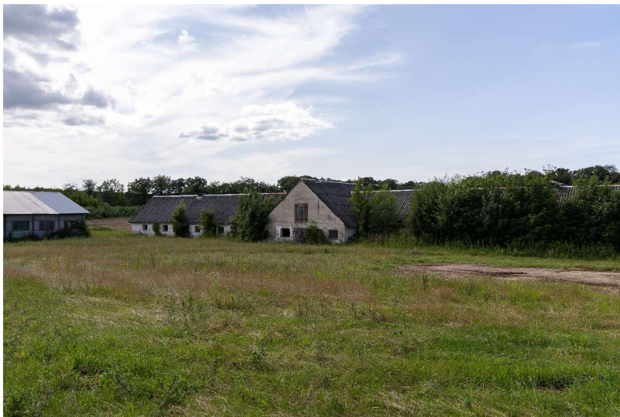
Zdjęcie 10. Istniejąca zabudowa w granicach projektu planu
