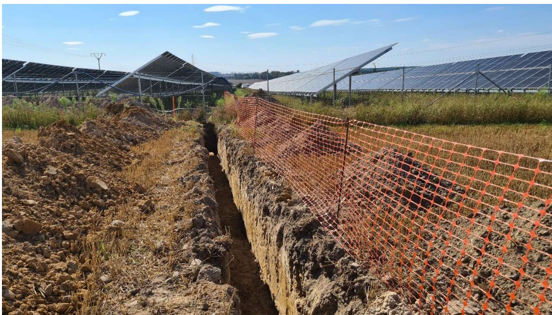
Zdjęcie 14. Wykop pod linie kablowe (zdjęcie wykonane przez autora prognozy)
