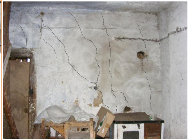
Fot. 4.1. Aktualny stan techniczny pomieszczenia Nr 1: nierówny, spękany gliniany tynk sufitowy, ubytki ślepego pułapu, wyraźne deformacje stropu wymagające stemplowania nadmiernie ugiętych belek oraz liczne zarysowania wewnętrznych ścian nośnych
