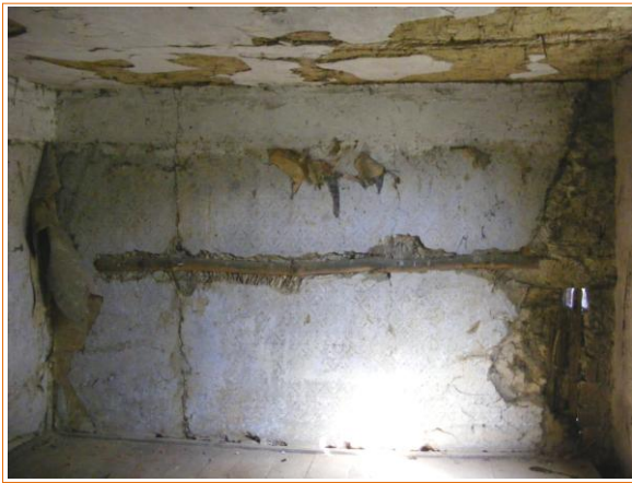
Fot. 4.5. Aktualny, zły stan techniczny pomieszczenia Nr 11: strop kwalifikujący się w całości do wymiany, spękana z lokalnymi ubytkami wypełnienia, silnie zdeformowana pn.-wsch. ściana szczytowa
