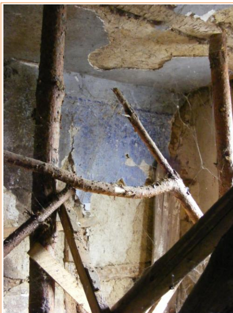
Fot. 3.2. Fatalny stan techniczny pomieszczenia Nr 2: spękany, nierówny z licznymi ubytkami tynk sufitowy, zbutwiałe, rozluźnione w węzłach oraz porażony biologicznymi szkodnikami drewna szkielet nośny ścian, wątpliwej jakości stemplowanie nadmiernie ugiętych belek stropu nad parterem, stan techniczny sąsiedniego pomieszczenia Nr 3 jest zbliżony do pomieszczenia Nr2
