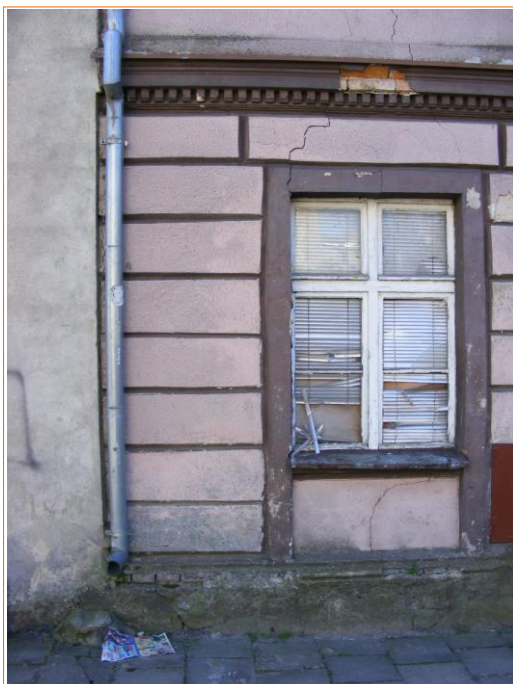
Fot. 3.6. Aktualny stan ściany frontowej w obszarze osi okien usytuowanych przy północno-wschodniej ścianie szczytowej budynku nr 29
