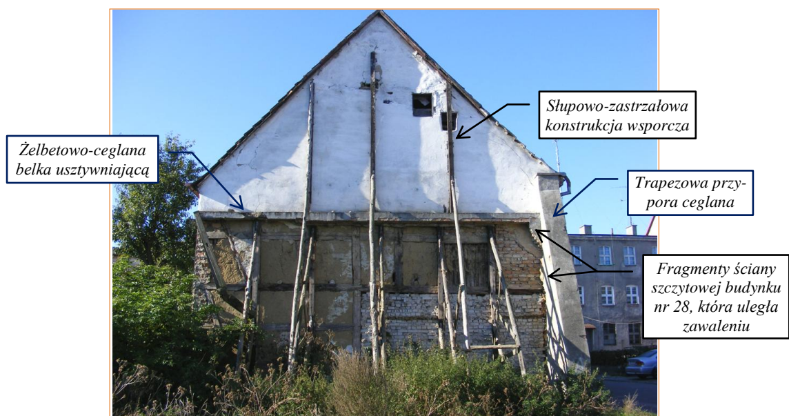
Fot. 3.3. Ogólny widok pn.-wsch. ściany szczytowej budynku przy ul. Konopnickiej 29
