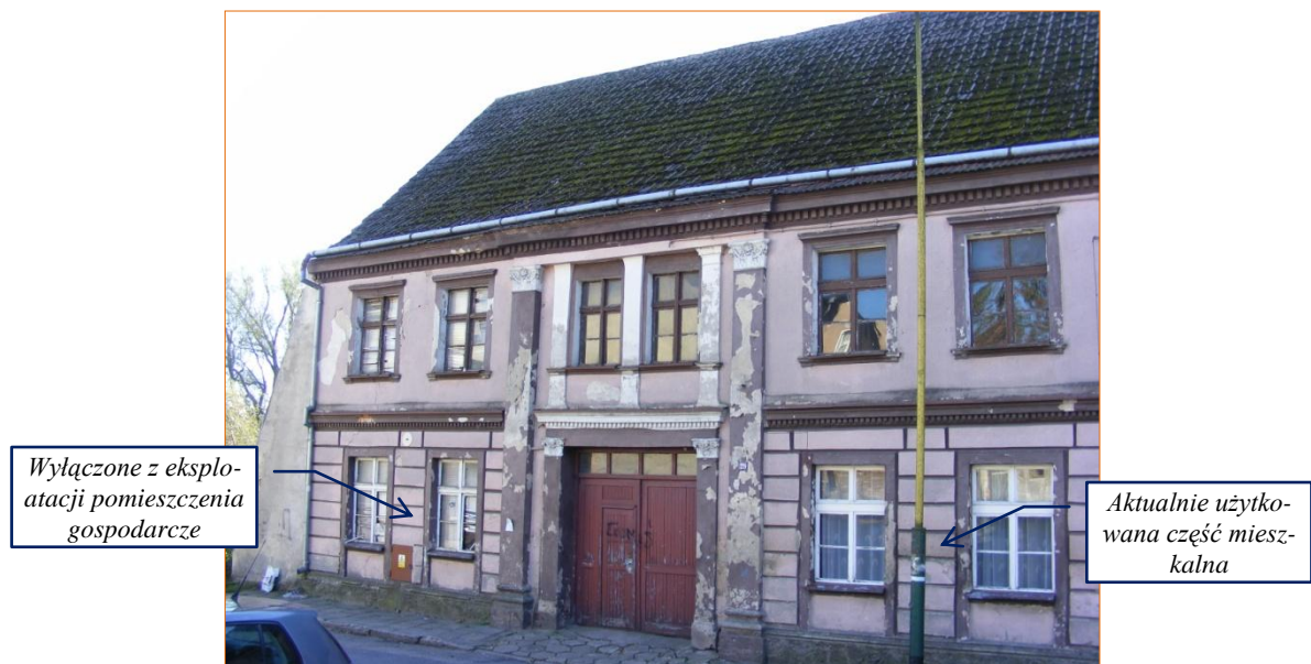
Fot. 3.1. Widok budynku od strony parkingu usytuowanego przy ul. Konopnickiej
