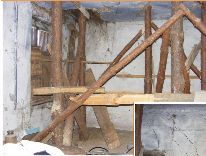
Fot. 4.1. Aktualny stan techniczny pomieszczenia Nr 1: nierówny, spękany gliniany tynk sufitowy, ubytki ślepego pułapu, wyraźne deformacje stropu wymagające stemplowania nadmiernie ugiętych belek oraz liczne zarysowania wewnętrznych ścian nośnych
